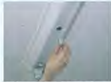
②グロー式の場合はグロー球を取外します。 ※必ず取外して下さい。グロー球を外さずに取付けると、LED蛍光灯の故障原因になります。
