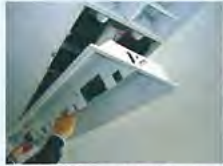
③蛍光灯器具を取外します。 ※器具によってはネジ留めしてある場合もありますのでご注意下さい。
