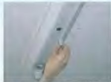
②次にグロー球を取外します。 ※必ず取外して下さい。グロー球を外さずに取付けると、LED蛍光灯の故障原因になります。
